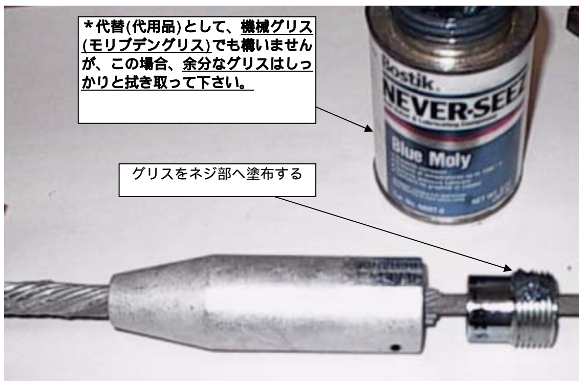
写真h：ネジ部には腐食防止用グリスを塗ること
